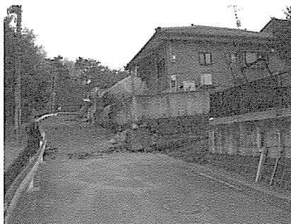
【滑動崩落被害・宮城県仙台市】3
