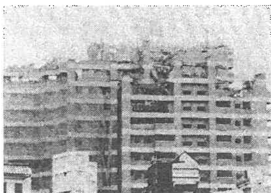
工事中の高層マンション
