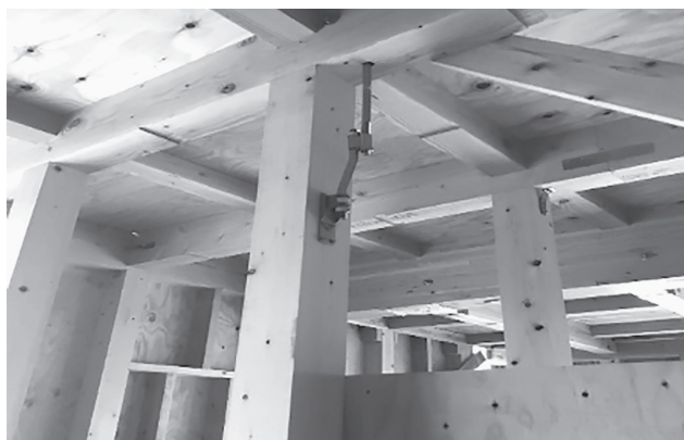
梁と柱を結合するアンカーボルト
