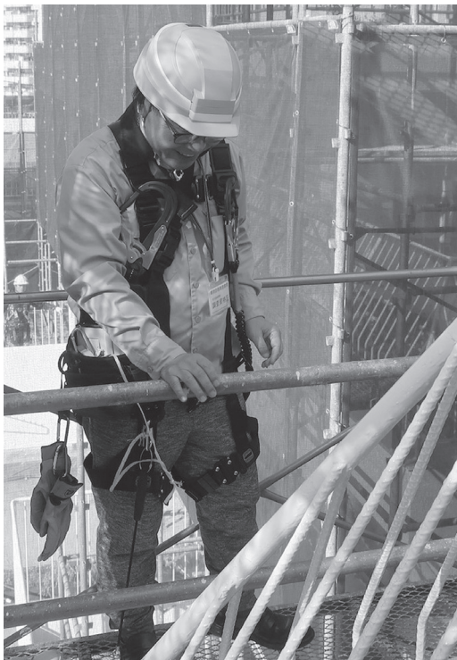
工事監理の風景
