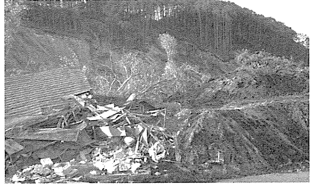
(b) 斜面崩壊後の道路整備後の様子
