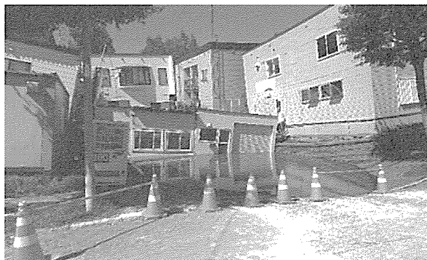
(b) 地盤沈下により住宅の冠水
