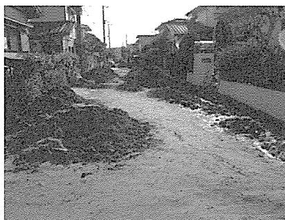
【液状化被害・千葉県千葉市】
